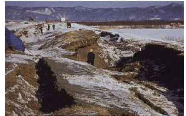
泥炭地盤上盛土の被災事例（十勝沖地震）
